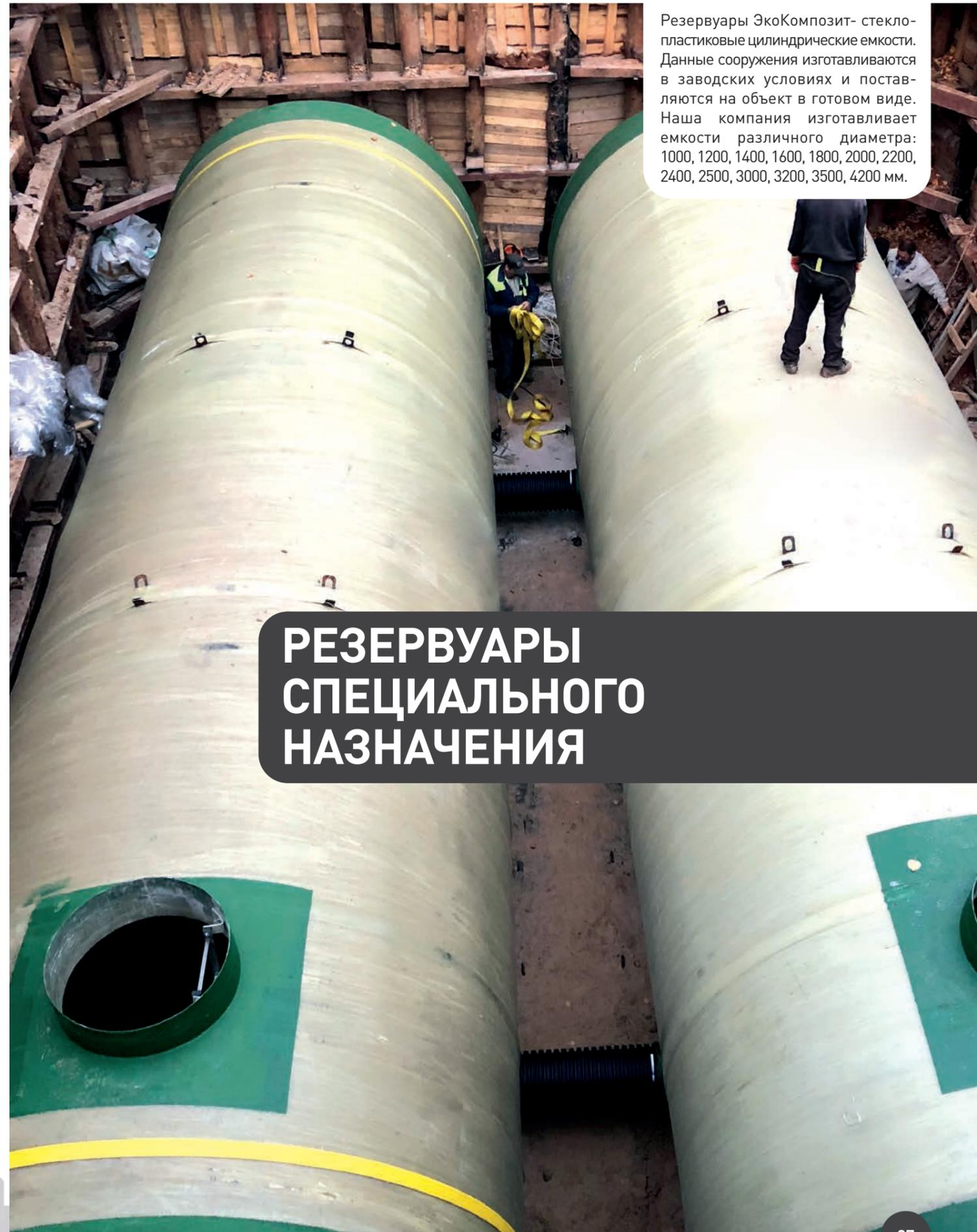
Резервуары ЭкоКомпозит- стеклопластиковые цилиндрические емкости. Данные сооружения изготавливаются в заводских условиях и поставляются на объект в готовом виде. Наша компания изготавливает емкости различного диаметра: 1000, 1200, 1400, 1600, 1800, 2000, 2200, 2400, 2500, 3000, 3200, 3500, 4200 мм.
