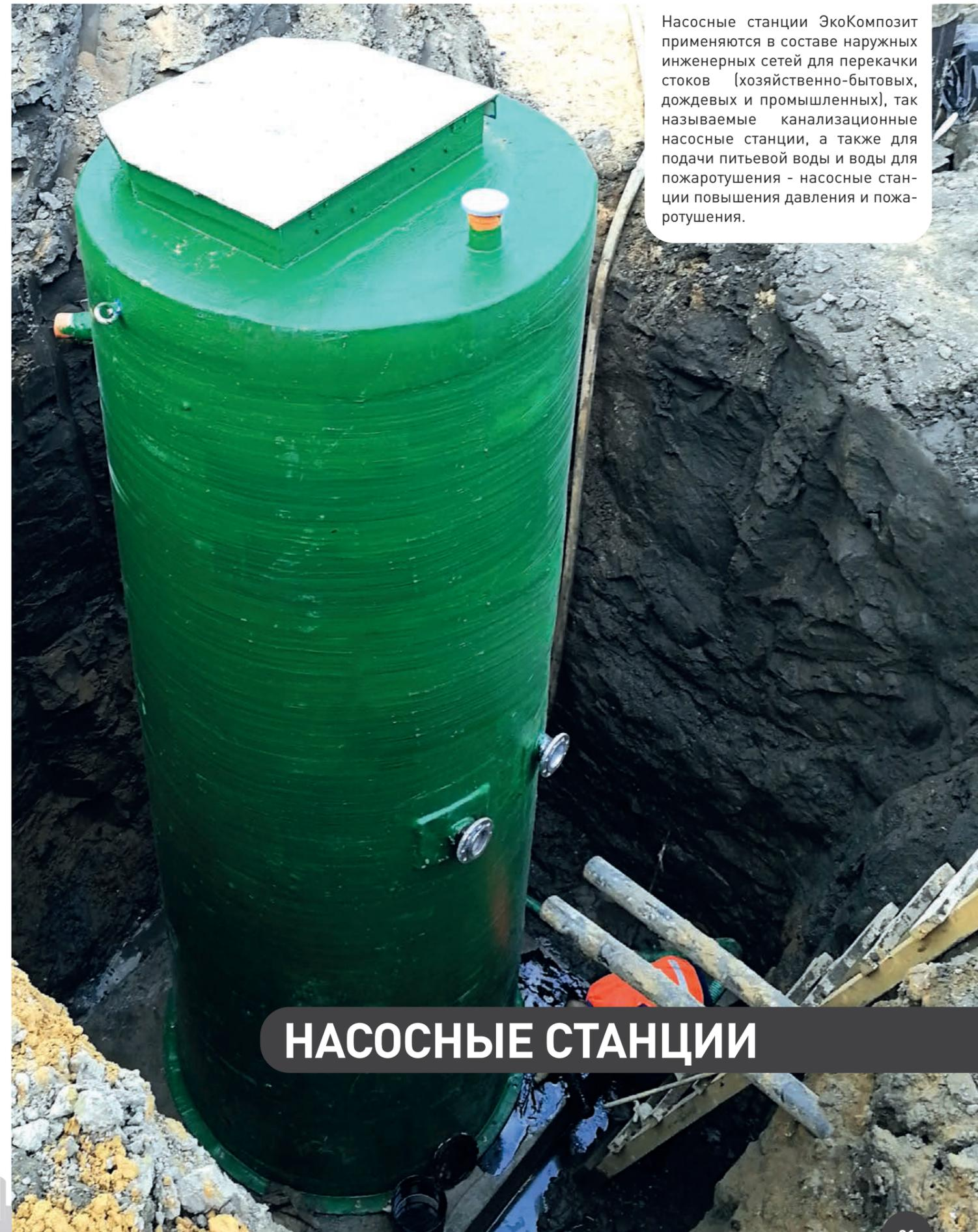
Насосные станции ЭкоКомпозит применяются в составе наружных инженерных сетей для перекачки стоков (хозяйственно-бытовых, дождевых и промышленных), так называемые канализационные насосные станции, а также для подачи питьевой воды и воды для пожаротушения - насосные станции повышения давления и пожаротушения.
