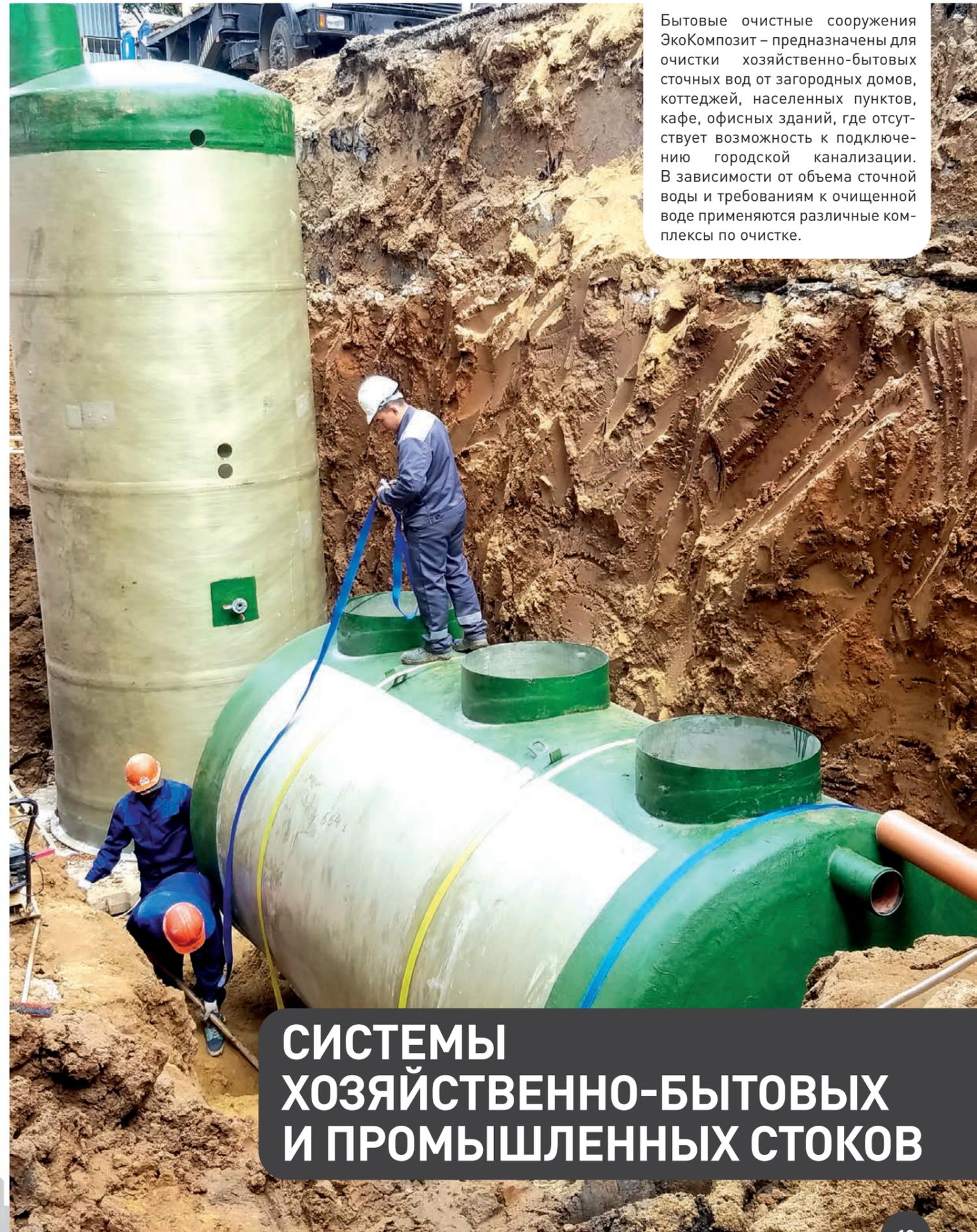
Бытовые очистные сооружения ЭкоКомпозит – предназначены для очистки хозяйственно-бытовых сточных вод от загородных домов, коттеджей, населенных пунктов, кафе, офисных зданий, где отсутствует возможность к подключению городской канализации. В зависимости от объема сточной воды и требованиям к очищенной воде применяются различные комплексы по очистке.
